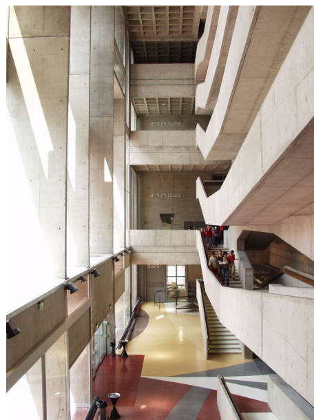
Le centre administratif de la Ville de Pantin, Jacques Kalisz architecte 1964-1973. L'ensemble est devenu le Centre national de la Danse et a reçu le prix de l'équerre d'argent en 2004 (E. Lohr, Service du patrimoine culturel de la Seine-Saint-Denis, 2003).
